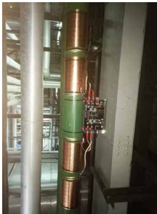
安装Vulcan S25来处理旧冷水机。
