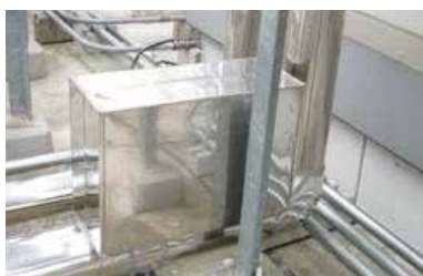
Vulcan S25 安装在补给水管道上, 为处理流经冷却塔A、B和C的水
