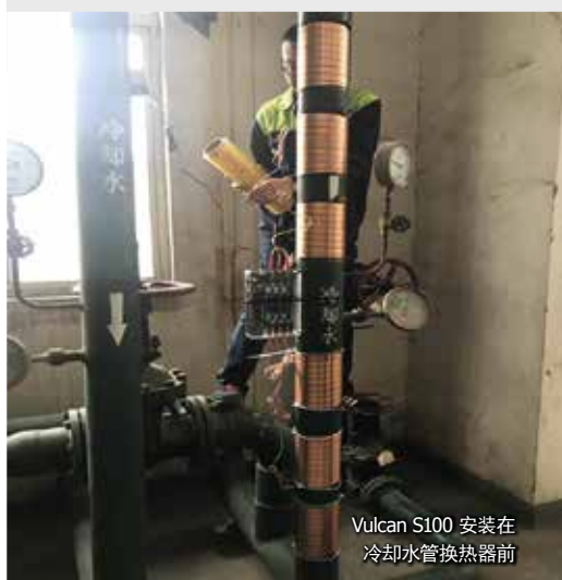
Vulcan S25 安装在冷却水管换热器前
