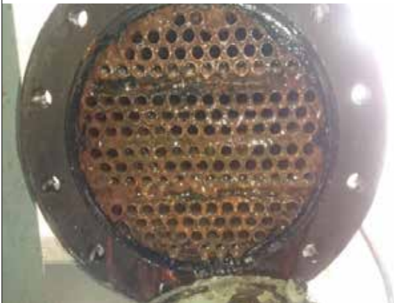
沃肯(Vuclan)安装前的换热器
