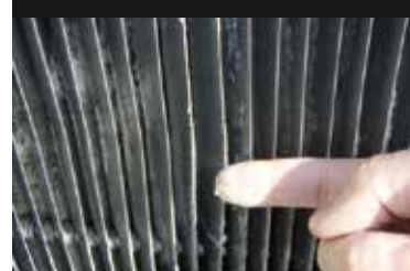
水能轻易把二氧化硅冲刷掉(残留的二氧化硅用手指轻碰就能擦掉)。
