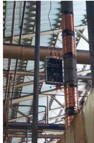
Vulcan S25安装在高周波热处理机前50米左右。
