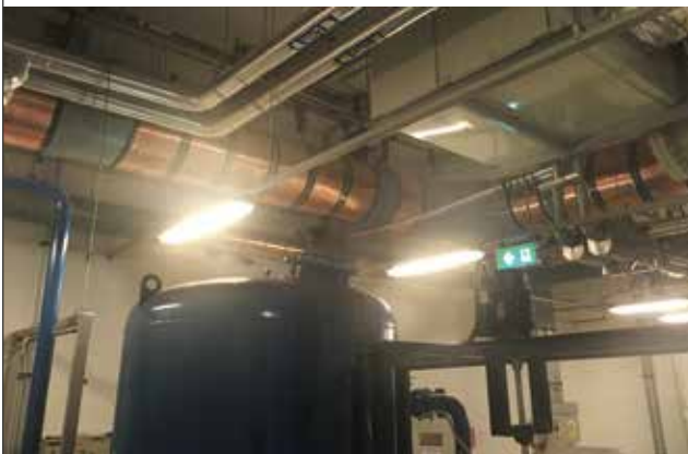
安装在冷凝器的回水管上的 Vulcan S250 和 X-Pro 1
