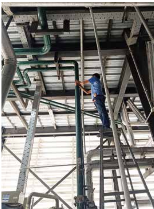
安装Vulcan S25来保护新的冷水机。
