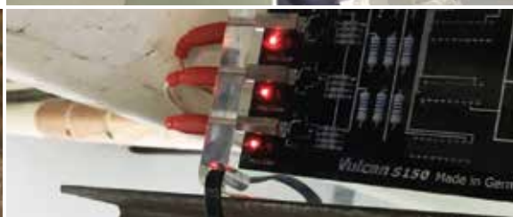
S150设备安装在无尘车间管道上，运用于处理注塑机用水结垢情况
