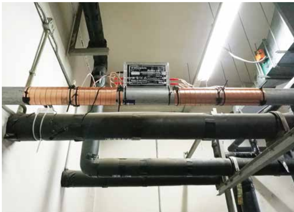
安装在冷却塔进水主管道上的Vulcan S25
