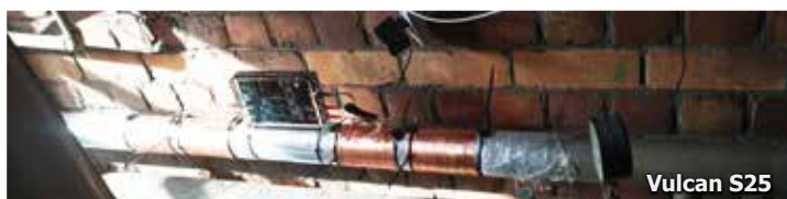
另外两组S25安装在两套供暖系统管路上
