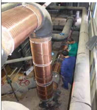
Vulcan S500 安装在CT机换热站。
