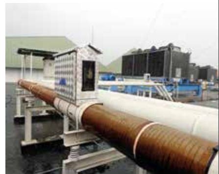
Vulcan S500位于铝箱内, 安装在购物商圈 Supermal Karawaci的一个冷却塔主管上。
