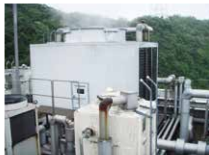
药厂冷却塔屋顶
