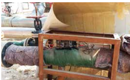
安装沃肯 (Vulcan) 前，将管道的铁锈与保温层除去，再安装脉冲带，最后将外部保温层恢复成原样
