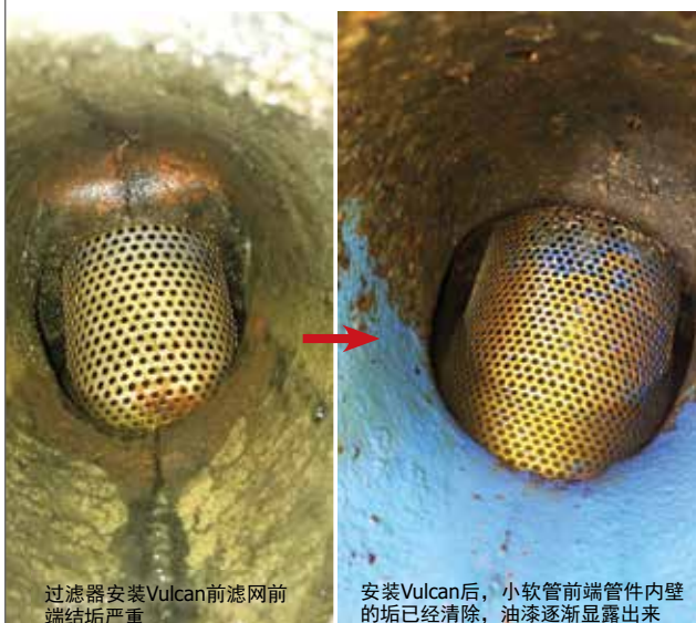
S150设备安装在无尘车间管道上，运用于处理注塑机用水结垢情况
