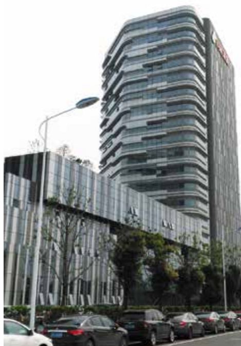
位于苏州的同程网总部大楼
