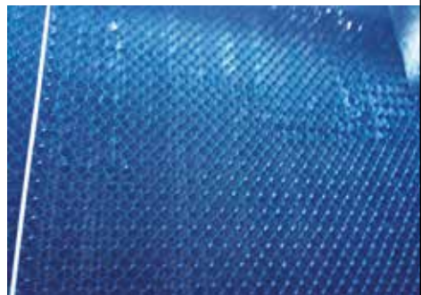
这张照片拍摄的是CT-1内部。安装沃肯(Vulcan)三周后，其处理过的水相接触的填料槽是干净的，而一些干燥的(未经处理的)区域仍然残留有绿色的生物膜。
