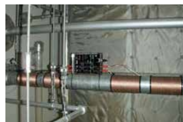
Vulcan S25 安装在循环管道上, 为处理流经冷却塔C的水
