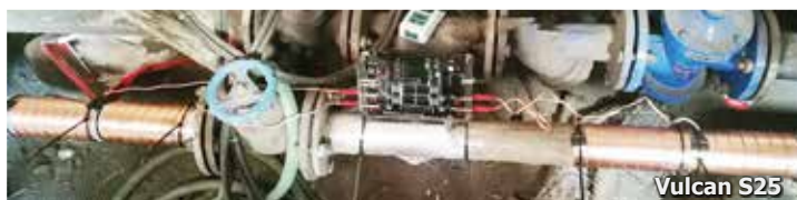
Vulcan S500 / S250 S500和S250分别安装在两个冷却水进水主管路上
