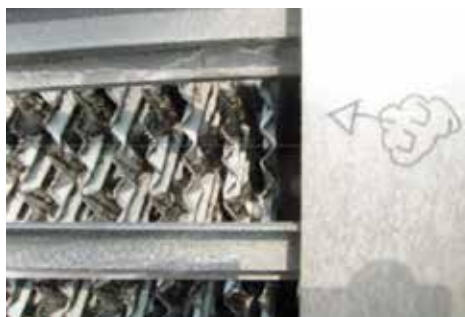
在安装沃肯(Vulcan)之前: 冷却塔外部
