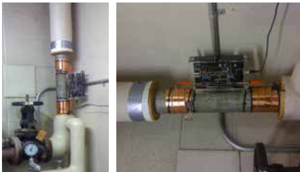
沃肯 (Vulcan) 抑垢除锈装置安装在罗斯福学校整栋建筑主水源
