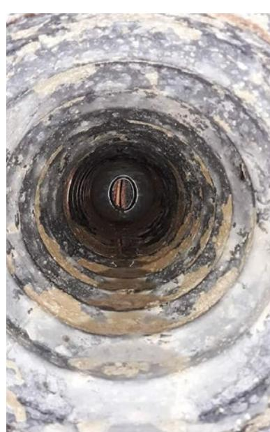
Les dépôts calcaires ont pu facilement être nettoyés à l'aide d'un pistolet à eau.
