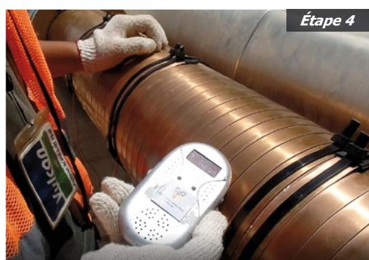
Vérifier le fonctionnement de Vulcan à l'aide d'un détecteur d'impulsions.
