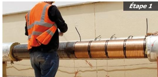
Tout d'abord, enrouler le tuyau de plastique afin de protéger les bandes à impulsion contre la condensation de la conduite.
