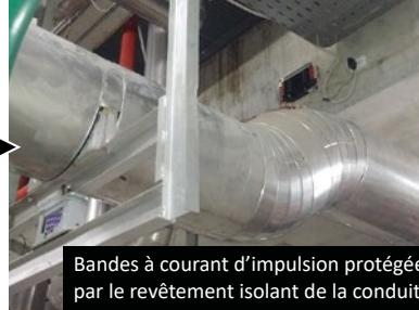
Bandes à courant d'impulsion protégées par le revêtement isolant de la conduite
