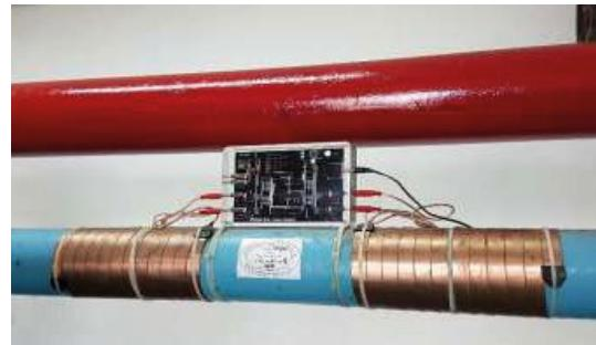
Le dispositif anti-calcaire électronique Vulcan S25 installé
