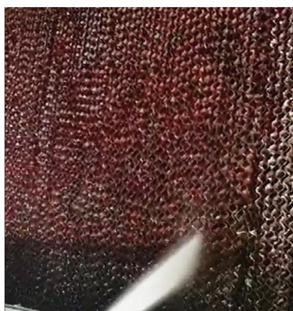
2 semaines après l'installation de Vulcan S10, l'ancien calcaire s'est assoupli et le nouveau calcaire s'est transformé en poudre. Le nouveau calcaire a été nettoyé facilement tandis que l'ancien calcaire a demandé plus de temps et l'utilisation d'un canon à eau.
