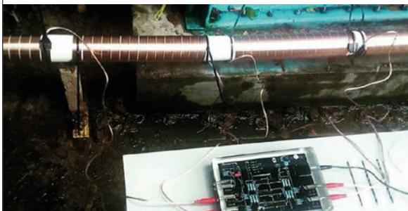
**Photo 1.** Installation de Vulcan sur l'arrivée d'eau principale.
