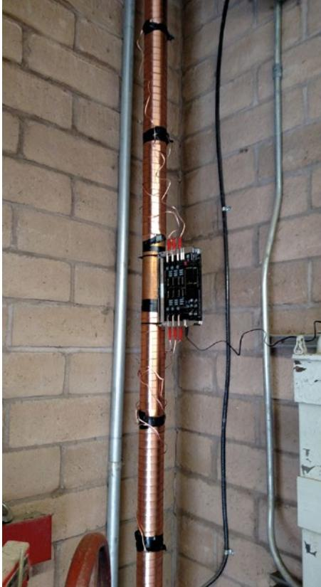
Vulcan S100 installé pour traiter l'eau de la conduite principale
