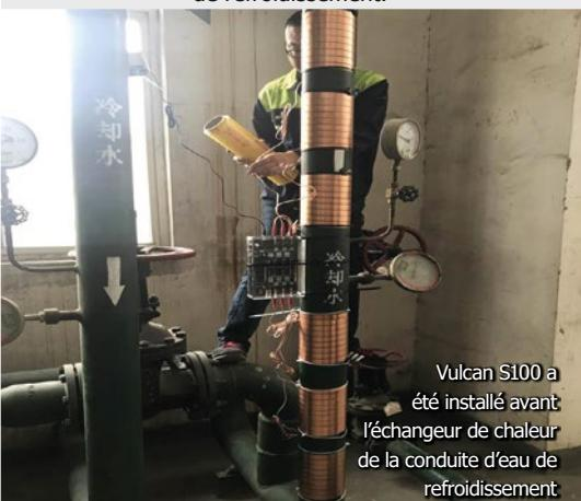
Vulcan S100 a été installé avant l'échangeur de chaleur de la conduite d'eau de refroidissement.
