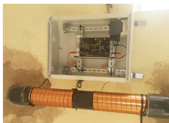
Vulcan S10 a été installé sur la conduite d'eau principale afin de traiter les 6 systèmes de refroidissement des 3 élevages de poulets.
