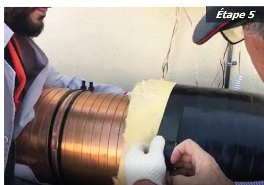
Pour terminer, apposer une couche isolante pour recouvrir complètement les bandes à impulsion et les protéger des éléments.
