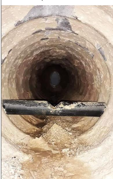
**6 mois** après l'installation de Vulcan 25, la chaudière a été ouverte : le calcaire s'était amollie et déposé sur le côté.
