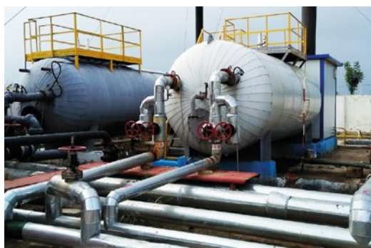
Entrada de agua de la calefacción del horno.
