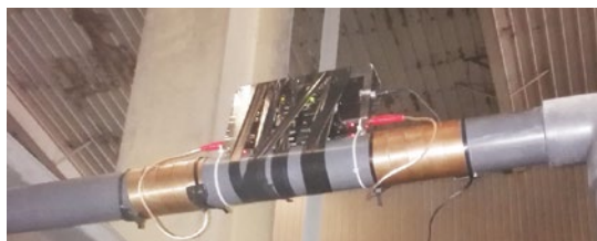
Vulcan S10 instalado antes de la membrana de ósmosis inversa.
