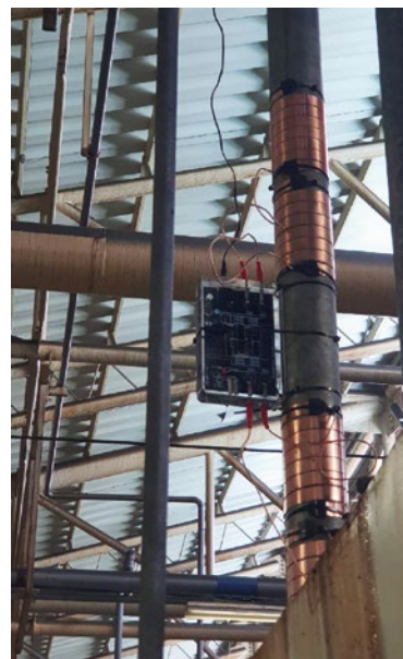
Vulcan S25 se instaló unos 50 metros antes de la máquina de temple por inducción.
