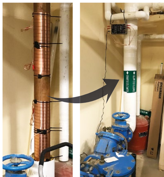
Paso 1: se instalaron las bandas impulsoras
