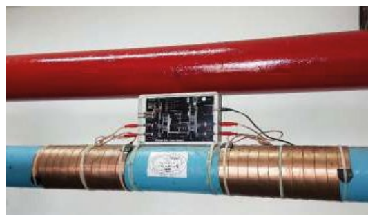
Instalación del sistema Antical Vulcan S25
