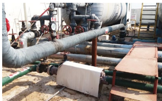
Instalación en el exterior con una cubierta hecha a medida para proteger la unidad del viento y el sol.
