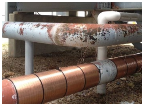
El equipo Vulcan S250 fue instalado en la tubería de 10" de diámetro que alimenta las torres de refrigeración gemelas (CT-1 y CT-2).
