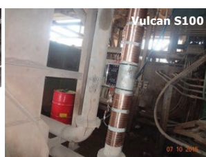
Intercambiador de calor tras 2 meses con Vulcan
