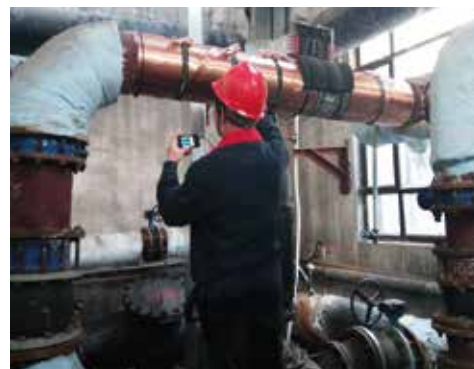
安装在进水母管上的 Vulcan S250
