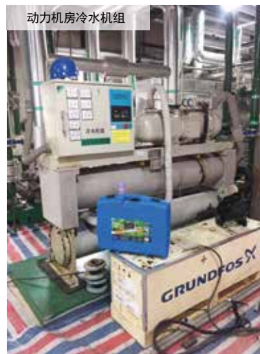
Vulcan S25 安装于冷却塔进出口管道，解决3号动力机房冷水机组结垢问题
