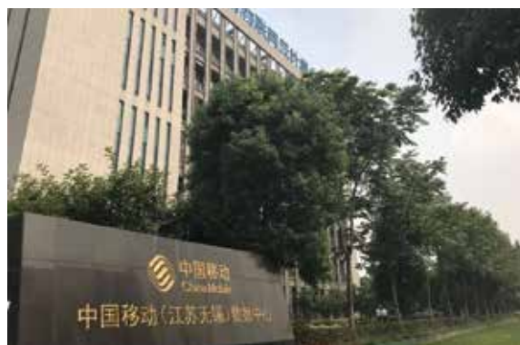
中国移动（江苏无锡）数据中心
