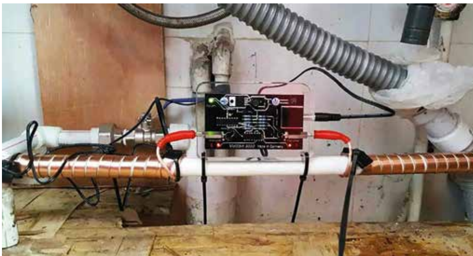
安装在家庭生活用水主管道的沃肯 (Vulcan) 装置 - V3000
