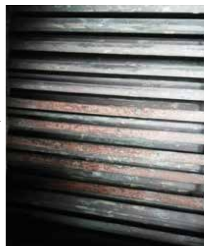
使用Vulcan S25一个月后的mf2冷却塔，水垢已经大幅脱落，期间没有再进行其他水处理
