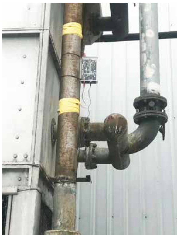
Vulcan S10 安装在冷却塔系统冷却水进水口
