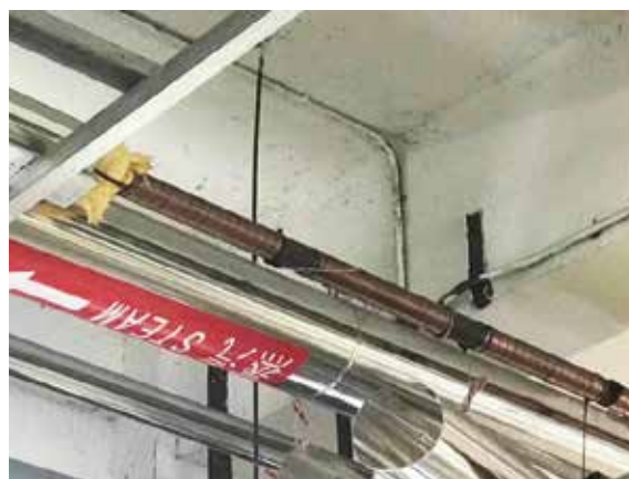
步骤1：安装脉冲带
