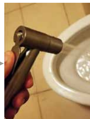
安装V3000三周后：水枪出水量已经有明显改善
