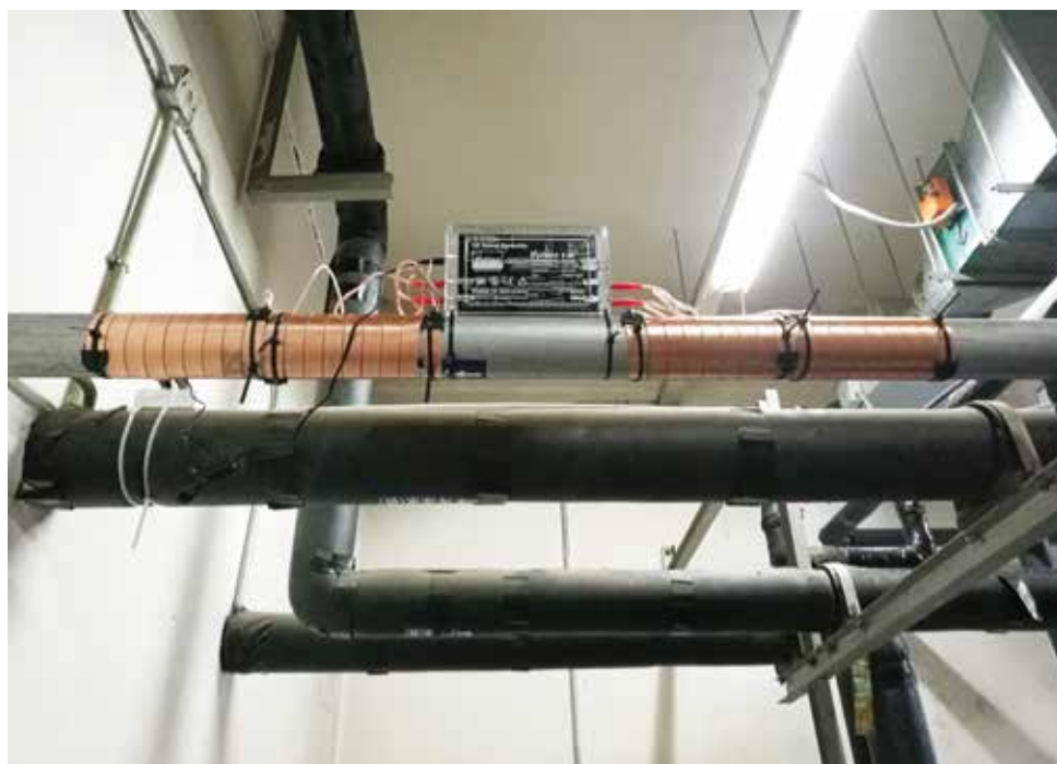
安装在冷却塔进水主管道上的Vulcan S25
