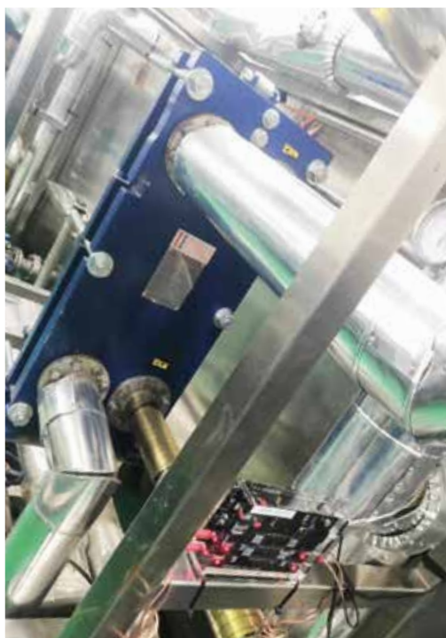
Vulcan S50 安装在杀菌机前面
