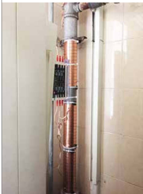
Vulcan S100 安装在学生宿舍里主水管道上
