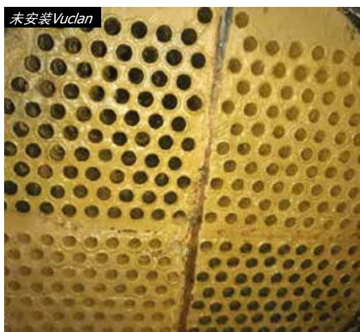
安装沃肯(Vulcan)前，水垢在换热器管内非常厚且坚硬
