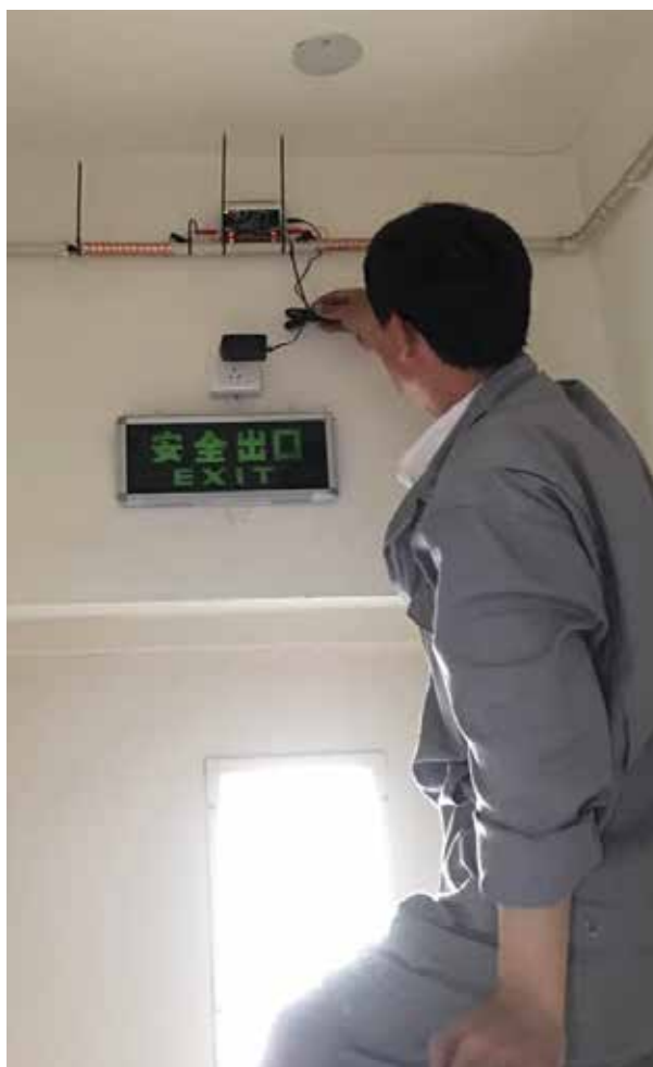
沃肯(Vulcan)安装在该小区的一家住户，在楼梯口处的家庭用水主管道上
