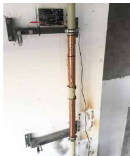
Vulcan S10 安装在啤酒 生产工艺用水进水口
