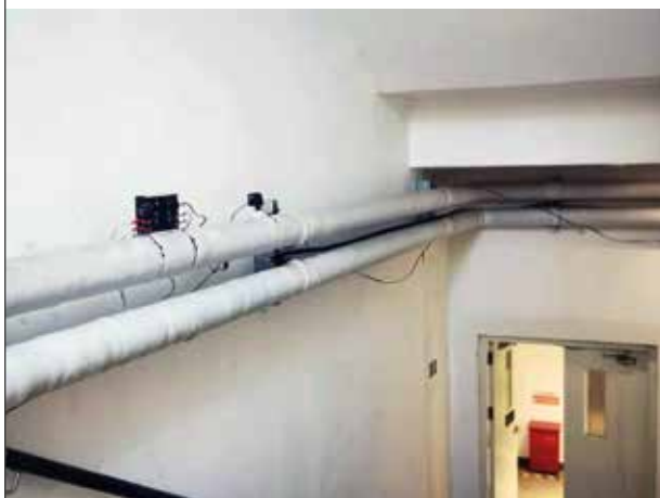
Vulcan S25安装在楼梯间通往热泵的主管路上
