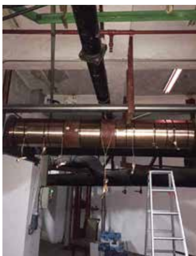
步骤1：安装脉冲带
