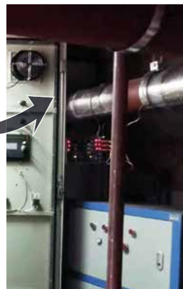
第2步：将Vulcan S100安装在水管上并包裹脉冲带保护层
