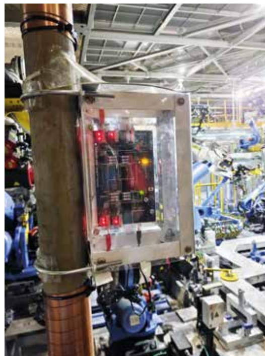
Vulcan S25 安装在机器人循环水系统总管径上
