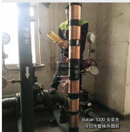
Vulcan S25 安装在冷却水管换热器前
