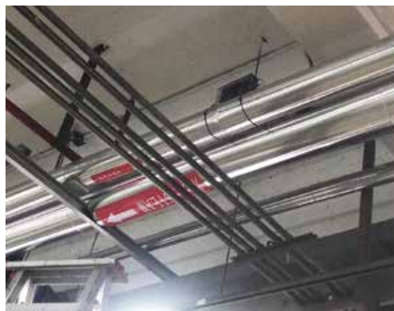
步骤2：管道包裹保温棉，再装上S25主机
