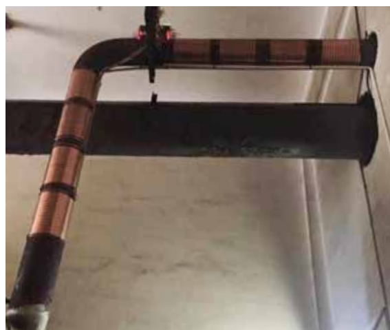
Vulcan 250 安装在纺织设备冷却循环水主管道
