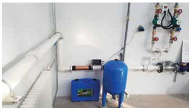
Vulcan S10 安装在A.O.史密斯热水器前
