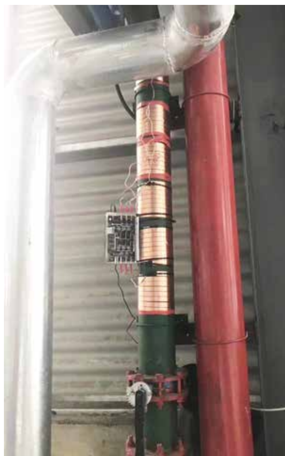
Vulcan S100 安装在模温机进水口主管道
