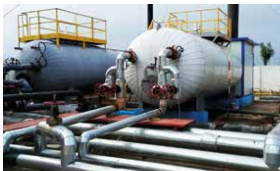
加热炉进水口
