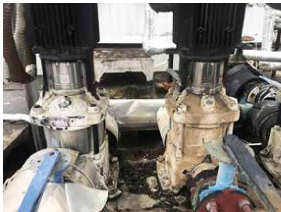
左边是安装Vulcan S25 二个月后的管道(无水垢)，右边则未做水处理
