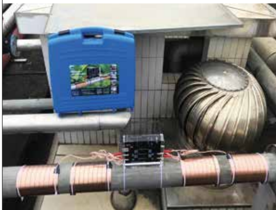
Vulcan S25 安装在B座客房整幢用水管道
