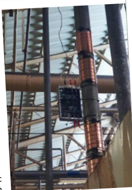
Vulcan S25 được lắp đặt cách 50 mét trước máy hàn cao tần.
