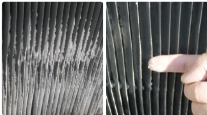
Các tấm fill trong tháp giải nhiệt
