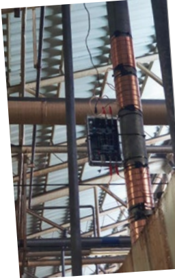
Vulcan S25, induksiyonla sertleştirme makinesinin yaklaşık 50 metre önünde kuruldu.
