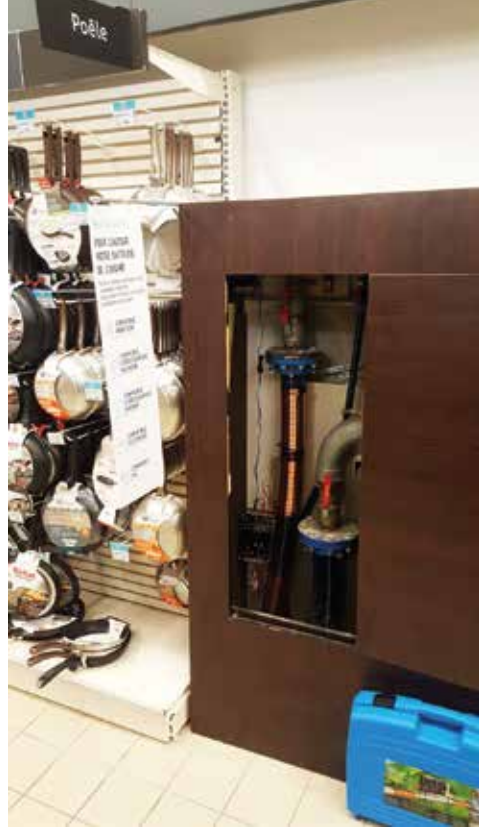
Vulcan S25, tüm binanın arıtılması için su şebekesine kuruldu.
