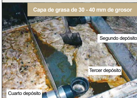
2º depósito – capa de grasa de 10 mm de grosor
