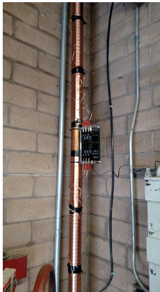
Vulcan S100 instalado en la tubería de agua principal.
