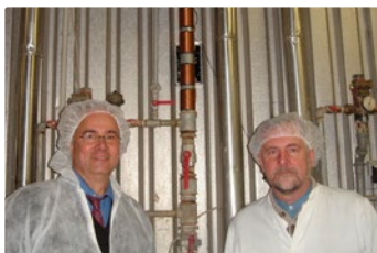
Pārtikas rūpnīcā uzstādīta Vulcan ierīce
