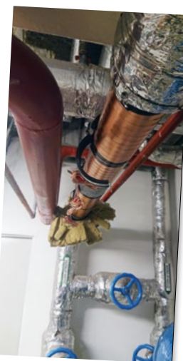
Un Vulcan S50 à l'entrée de l'alimentation principale du bâtiment A.
