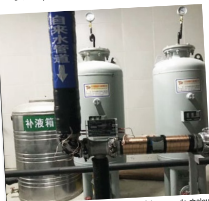
Vulcan S25 a été installé en face de l'échangeur de chaleur afin de résoudre les problèmes de calcaire touchant les échangeurs de chaleur, prolonger la fréquence d'entretien et renforcer l'efficacité.
