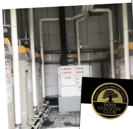
Sur les deux côtés de l'image se trouvent des échangeurs de chaleur. Sur les deux côtés de l'image se trouvent des échangeurs de chaleur.
