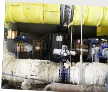
2 단계 : 외부 설치, 파이프에 단열재 (보온재)를 덮음. 보온 박스에 Vulcan X-PRO 2 설치.
