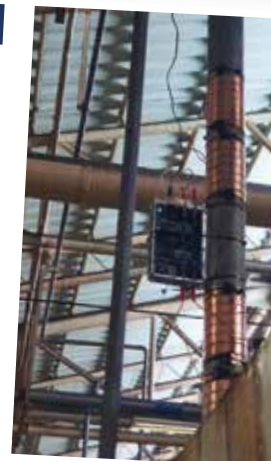
Vulcan S25 a été installé à quelque 50 mètres en amont de la machine de trempe par induction.
