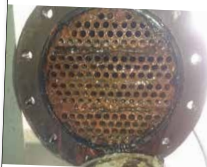
L'échangeur de chaleur avant l'installation de Vulcan
