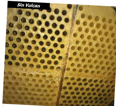
Antes de instalar Vulcan, las calcificaciones eran muy gruesas y duras en los tubos del intercambiador de calor.
