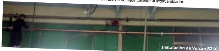
Instalación de Vulcan S250
