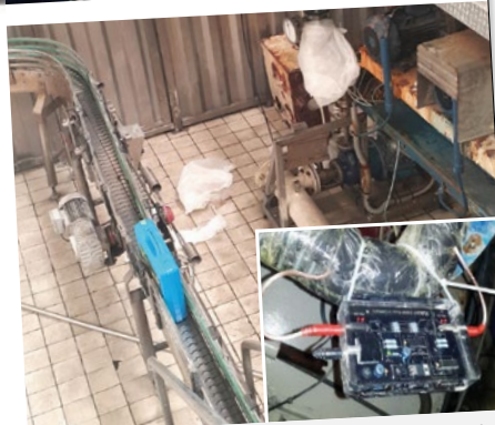
Vulcan 5000 se instaló en la entrada de agua del cuarto de reciclaje de agua.
