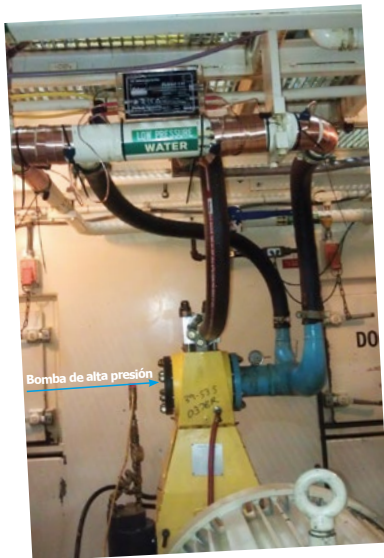
Vulcan S25 fue instalado en la estación de lavado de alta presión de la planta Chrysler ITP 2.
