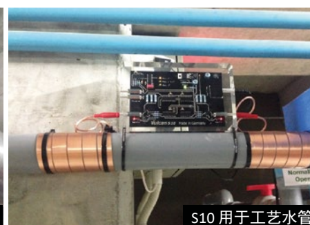
管道绝缘层覆盖脉冲带
