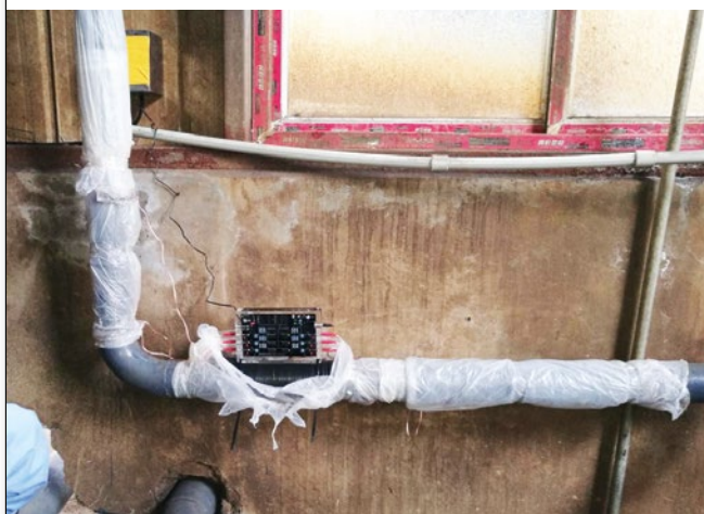
Vulcan S100 配套在污水房处理污泥脱水机
