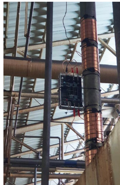
Vulcan S25安装在高周波热处理机前50米左右。
