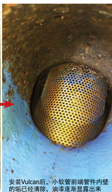
S150设备安装在无尘车间管道上，运用于处理注塑机用水结垢情况
