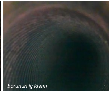
Soğutucu #3 Kondansatör Ø 67 cm, boru Ø 7/8", uzunluk: 418 cm
