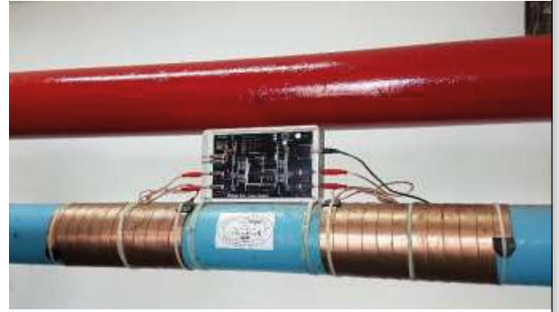
Kireç Önleyici Sistem Vulcan S25 kuruldu
