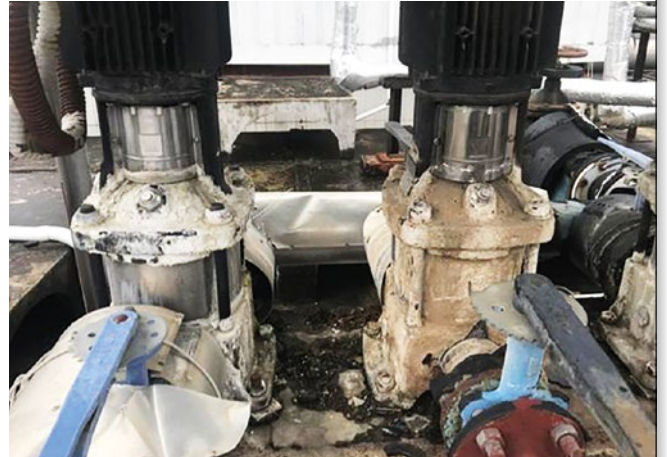
Solda, Vulcan S25'in 2 ay boyunca kurulmasından sonraki boru (kireçsiz); sağda ise herhangi su artışı olmayan boru bulunuyor.
