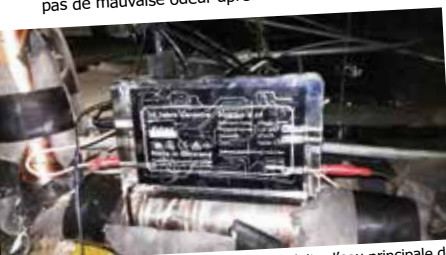
Vulcan S10 a été installé sur la conduite d'eau principale de la cuisine chinoise.
