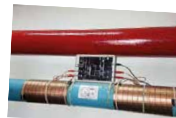
Le dispositif anti-calcaire électronique Vulcan S25 installé
