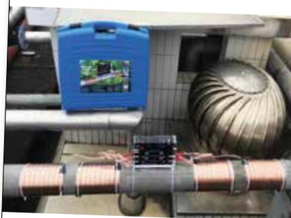
Vulcan S25 a été installé sur la conduite d'eau principale du bâtiment B des chambres d'hôtes.
