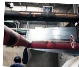
Vulcan S25 instalado en una tubería de cobre DN80.
