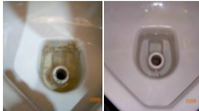
Cuvette de toilette
