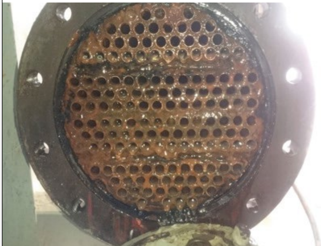
L'échangeur de chaleur avant l'installation de Vulcan
