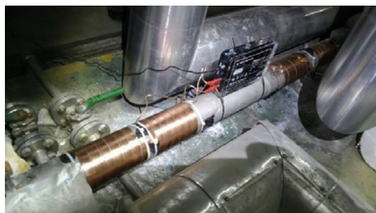
Vulcan S25 installé chez Toray Industries
