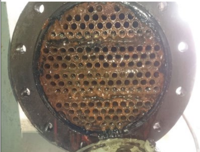
Intercambiador de calor antes de instalar Vulcan
