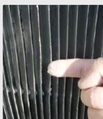
Rejillas de torres de refrigeración
