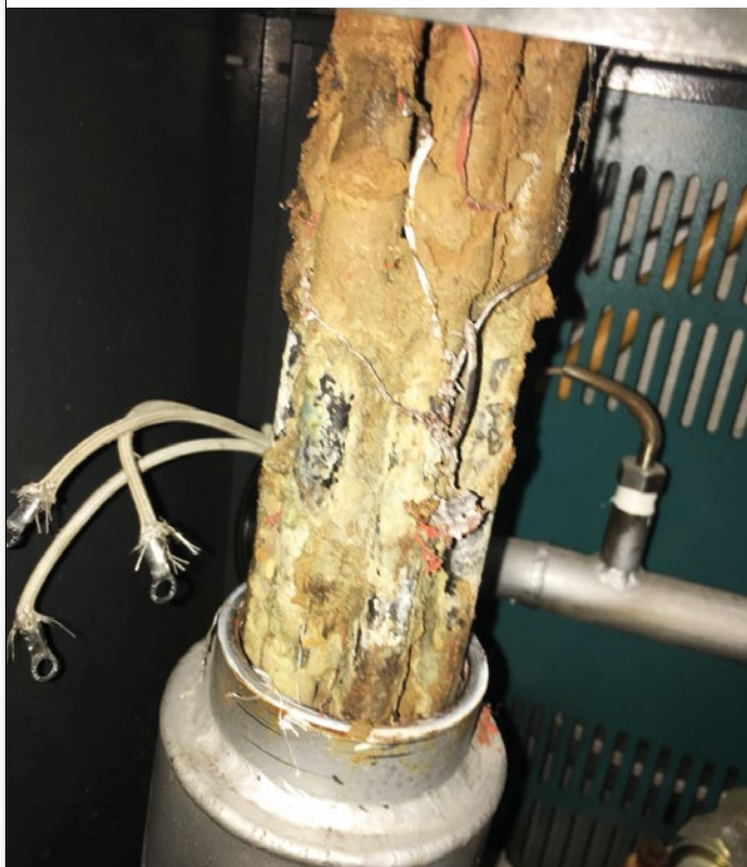
Intercambiador de calor sin mantenimiento por 3 años.
