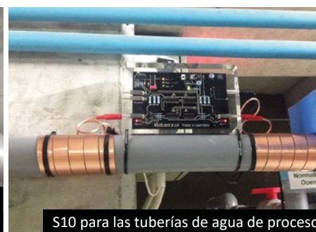
Bandas impulsoras recubiertas de aislamiento para tuberías
