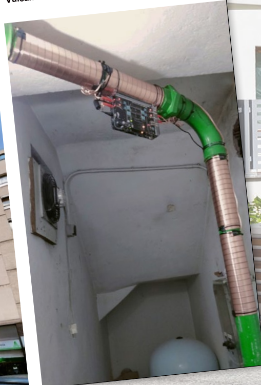
Vulcan S50 Conduite principale d'eau froide avec Ø 76
