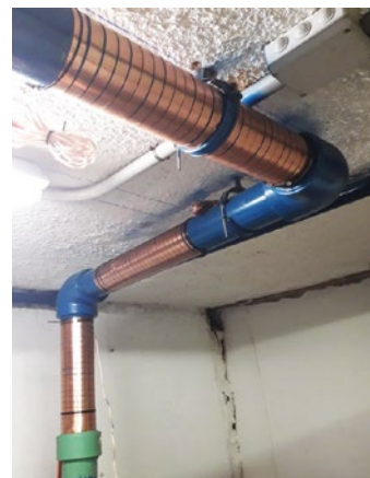
Étape 1 : Installer les bandes à courant d'impulsion
