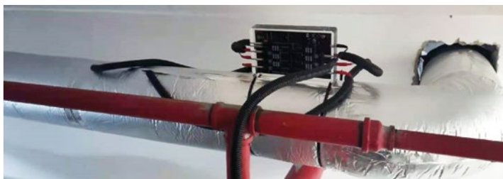
1 set de S100 a été installé sur le radiateur de l'eau de la pompe à chaleur dans le bâtiment n° 2 de l'immeuble
