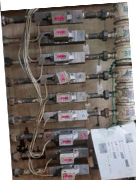
厂房内有9个带水表的二级小管, 水表用来观察并且确保稳定的流速。如果水管堵塞导致流速下降, 则会引起高周波热处理机不能正常运作。因此, 管道在安装沃肯(Vulcan)前, 必须每2-3个月清洗一次。
