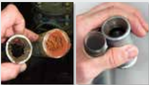
Sistema de tuberías
