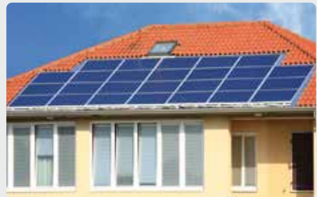
Солнечные панели на крыше частного дома
