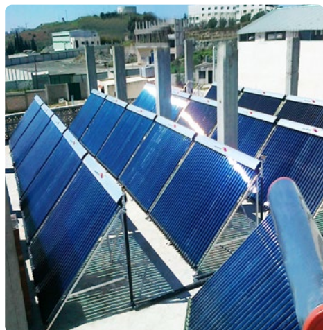
Kolektory słoneczne w domu mieszkalnym
