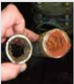
Sistema de tuberías
