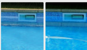
Linia osadu na ścianie basenu
