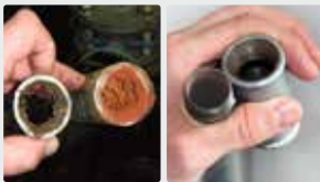
Sistema de tuberías
