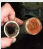
Sistema de tuberías
