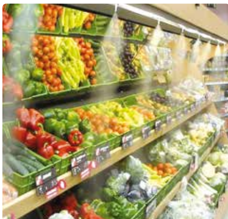
Форсунки системы увлажнения в продуктовой секции
