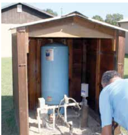
Система колодезного водоснабжения дома
