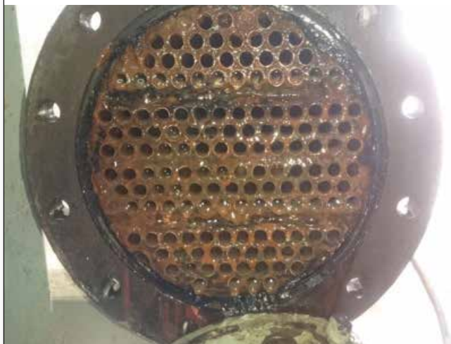
L'échangeur de chaleur avant l'installation de Vulcan
