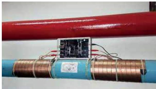
Le dispositif anti-calcaire électronique Vulcan S25 installé
