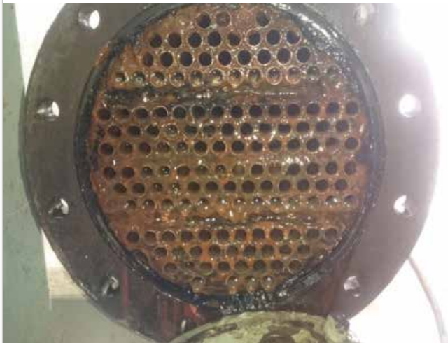
L'échangeur de chaleur avant l'installation de Vulcan
