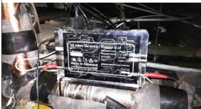
安装在中式厨房总管的Vulcan S10
