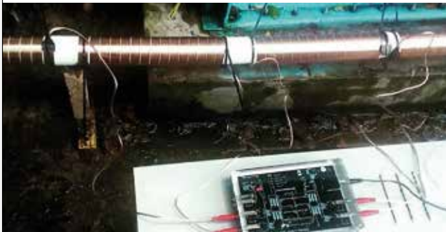
图1. 沃肯(Vulcan)安装在主进水管线上。
