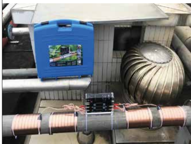
Vulcan S25 安装在B座客房整幢用水管道
