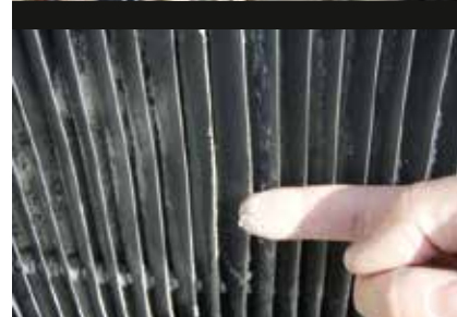
水能轻易把二氧化硅冲刷掉(残留的二氧化硅用手指轻碰就能擦掉)。
