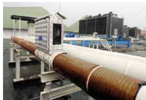
Vulcan S500位于铝箱内, 安装在购物商圈SMK的一个冷却塔主管上。
