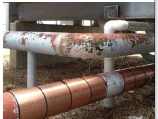
Vulcan S250安装在了一个给双冷却塔供水直径10英寸的管道上。(CT-1 和 CT-2)
