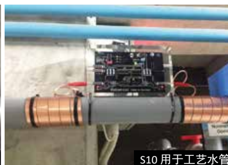
管道绝缘层覆盖脉冲带
