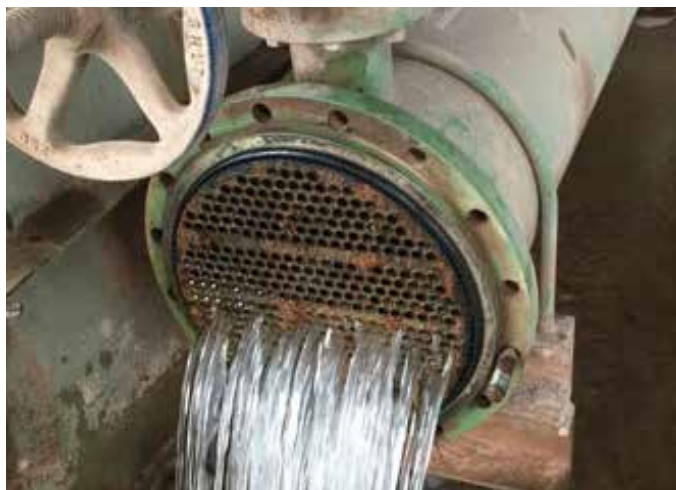
沃肯(Vuclan)安装两个月后的换热器
