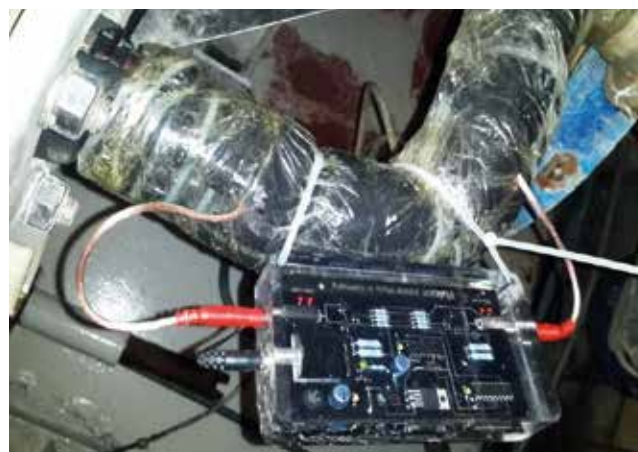
Vulcan 5000 安装在水循环室的进水口
