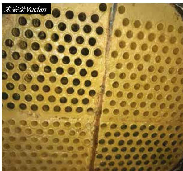
安装沃肯(Vulcan)前，水垢在换热器管内非常厚且坚硬
