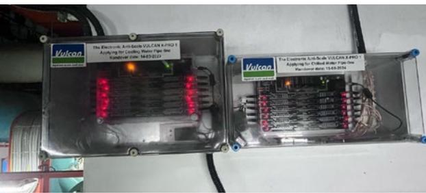
一台Vulcan X-Pro 1保护冷却塔循环管线。
