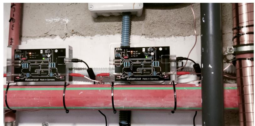
**2 x Vulcan S10** sur le circuit d'eau chaude avec Ø 32 mm
