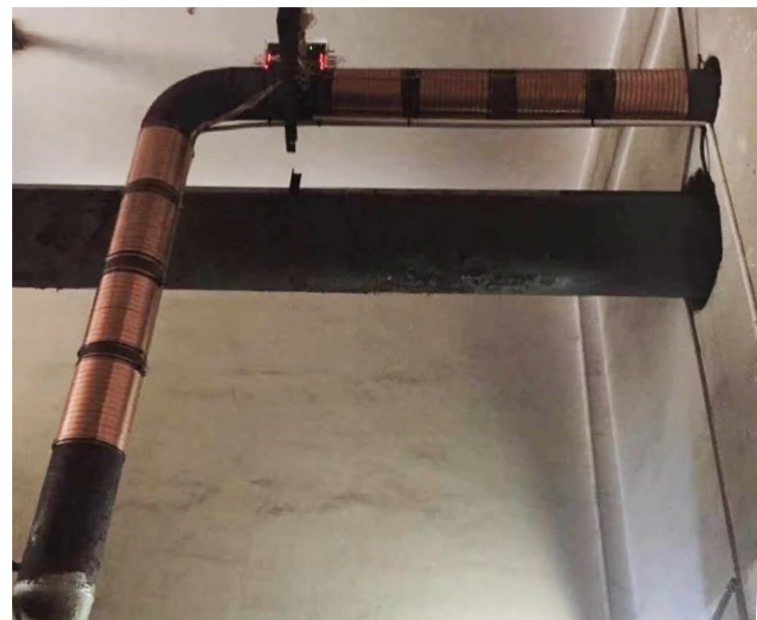
Vulcan S250 a été installé sur une seconde conduite d'eau de circulation du dispositif de filature.
