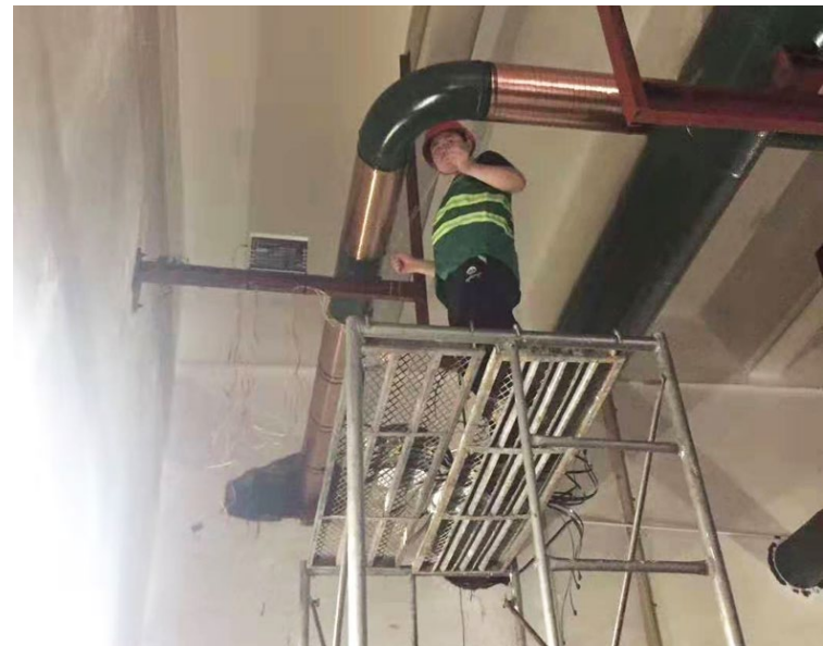
Vulcan S350 a été installé sur une des conduites d'eau de circulation du dispositif de filature.
