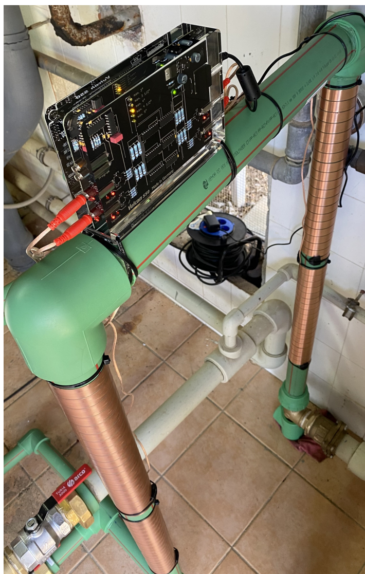
Vulcan S50 dans la conduite principale d'eau froide avec Ø 63 mm
