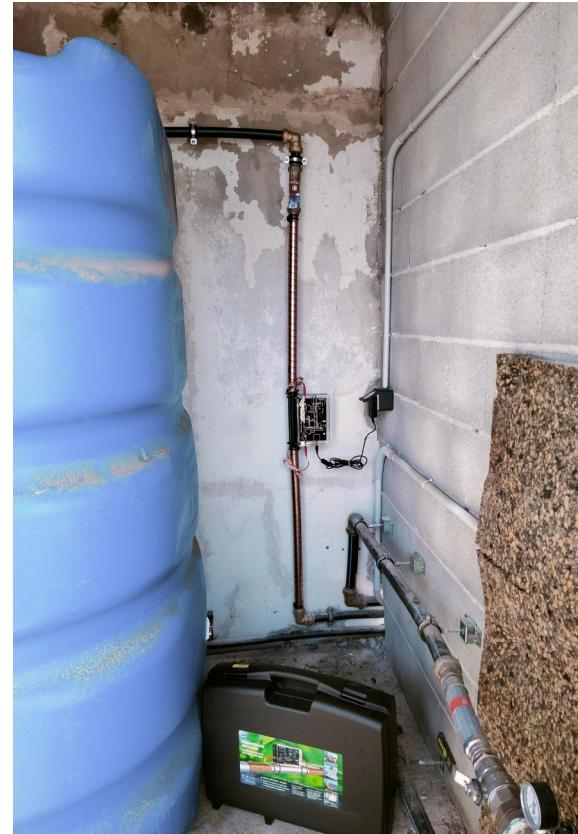
**Vulcan S10** au tuyau d'eau froide avec Ø 19 mm
