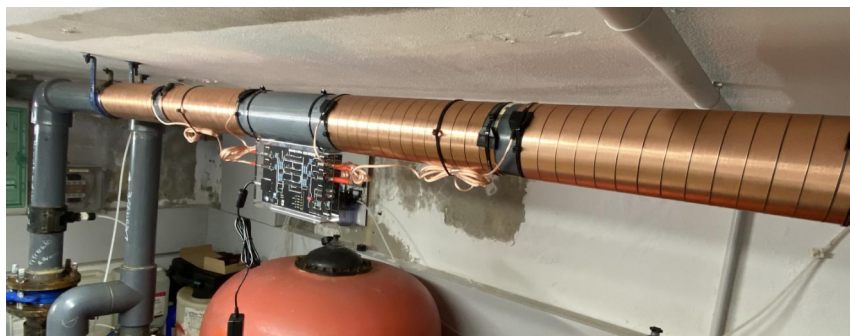
Vulcan S50 dans le circuit d'eau de la piscine n° 1 avec Ø 90 mm
