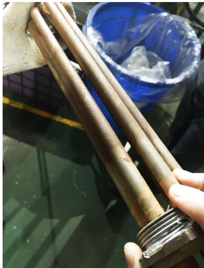
Tras un año y medio de la instalación de Vulcan, las incrustaciones han desaparecido sin mantenimiento adicional.
