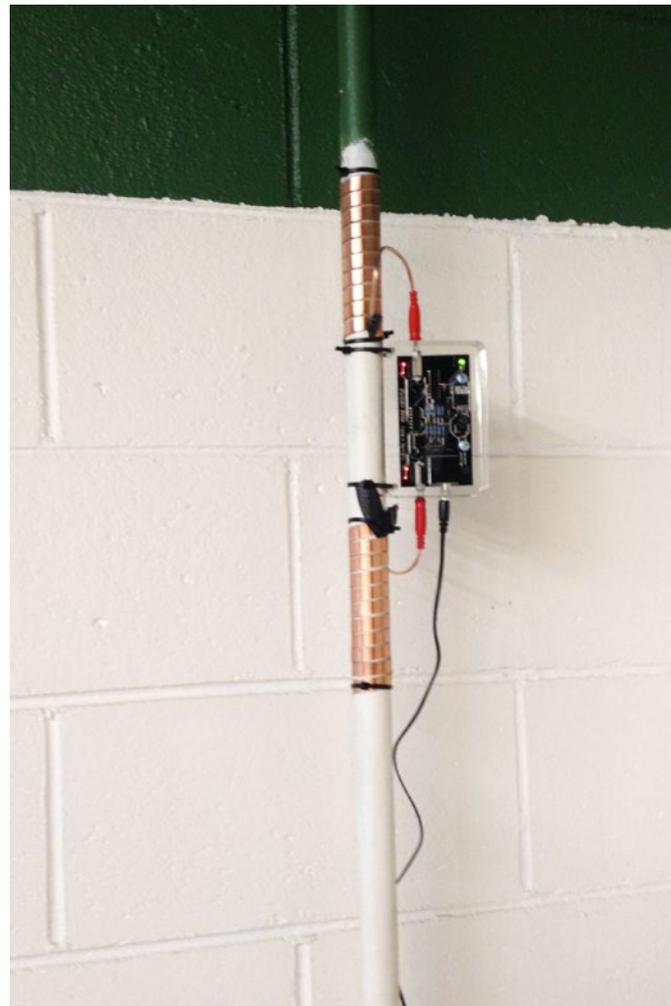
Vulcan S10 instalado en la tubería de agua principal.
