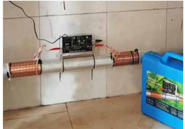
Vulcan 5000 fue instalado en una central térmica para tratar el agua de uso cotidiano con el fin de resolver los problemas de incrustaciones en el calentador y en el depósito de agua caliente.
