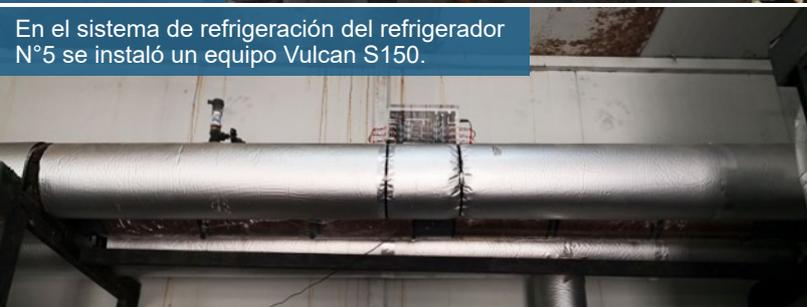
En el sistema de refrigeración del refrigerador N°5 se instaló un equipo Vulcan S150.
