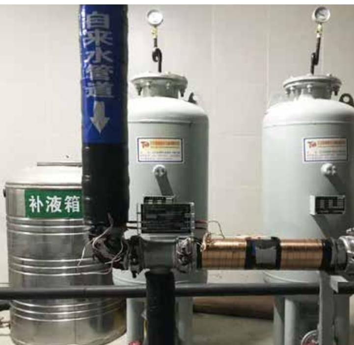
Vulcan S25 se instaló delante del intercambiador de calor para resolver problemas de incrustaciones en intercambiadores de calor, bombas, depósitos de agua, duchas y en todo el sistema de tuberías.
