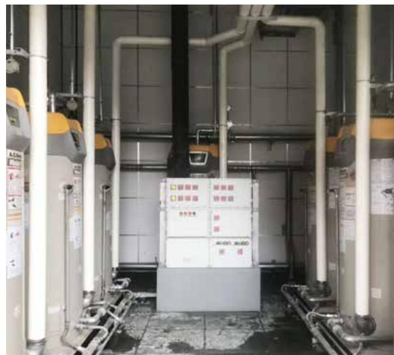
A ambos lados de la imagen se encuentran calentadores de agua, Vulcan S25 fue instalado en la entrada de agua de los calentadores.
