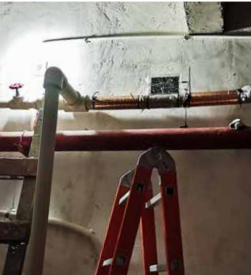
Vulcan S10 se instaló en la tubería principal de suministro de agua del hotel.
