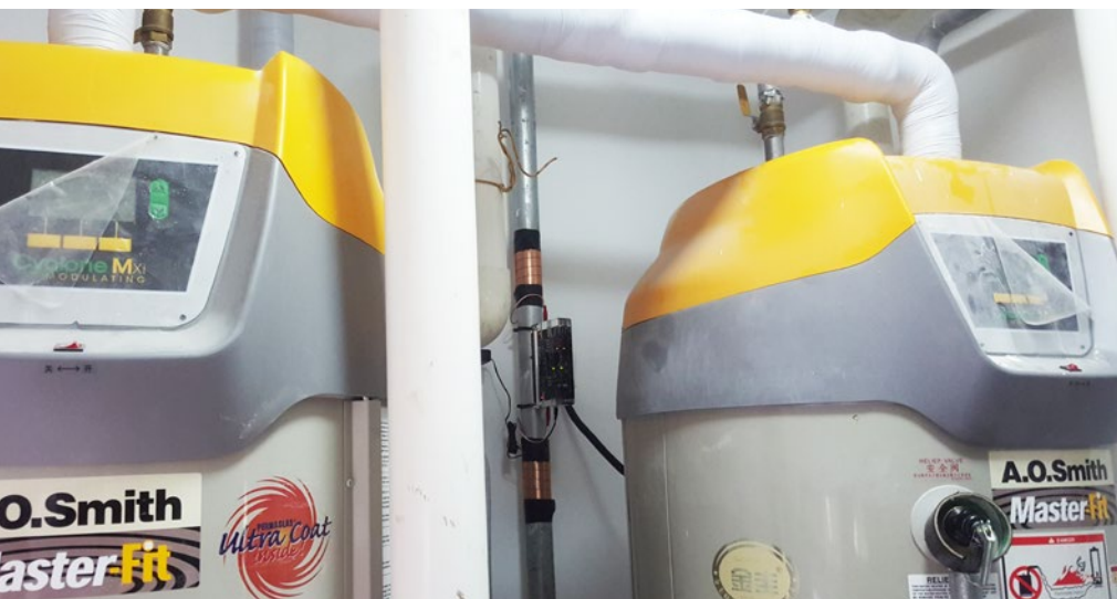
El Vulcan S10 trata el sistema de agua caliente para el área de oficinas.
