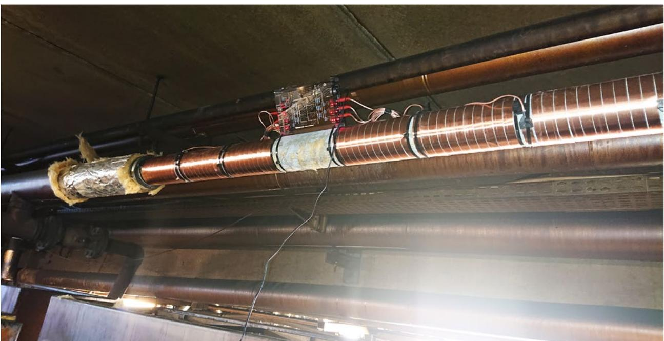
Se instaló Vulcan S100 en el tubo de entrada principal con el fin de resolver los problemas de incrustación de las cámaras de cocción y ahumado. Para instalar las bandas impulsoras se quitó el aislamiento de la tubería.
